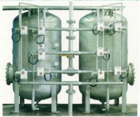
Система фильтрации воды для подачи в уплотнительные системы Safeclean гарантирует чистую воду для уплотнений. Данная система фильтрации очищает уплотнительную воду так эффективно, что остающиеся частицы или загрязнения не вызывают неисправностей в работе уплотнения или его излишний износ. Она также улучшает надежность устройств, регулирующих давление и течение, присоединенных к трубопроводу. Safeclean не только продлевает срок службы уплотнения, но также уменьшает расход воды.
